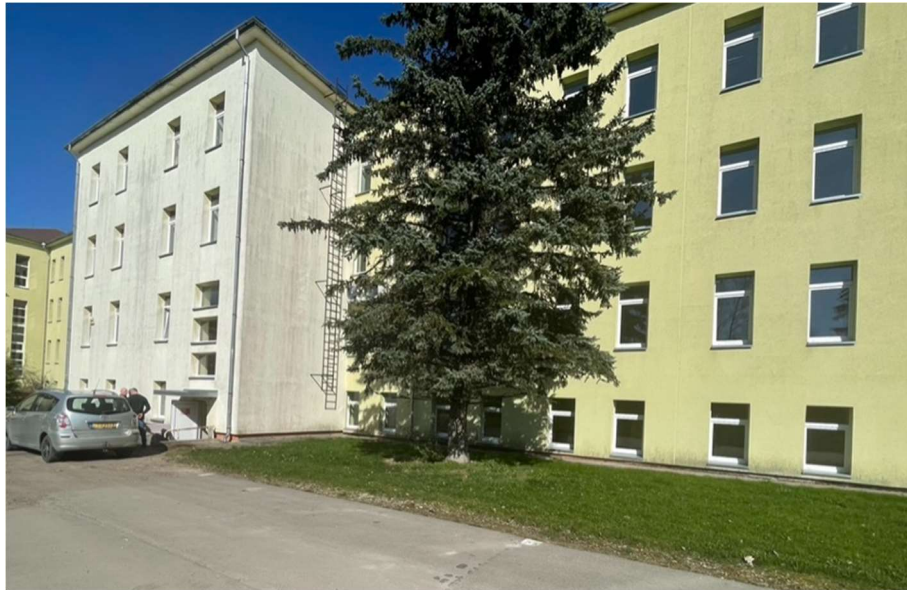
3 pav. Lifo šachtos įrengimo vieta.
