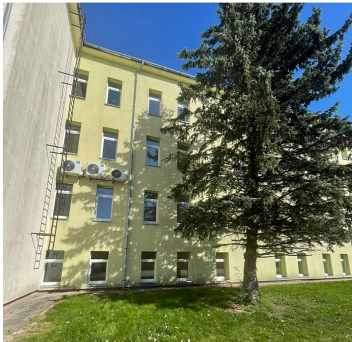
2 pav. Pastato fasado vaizdas.
